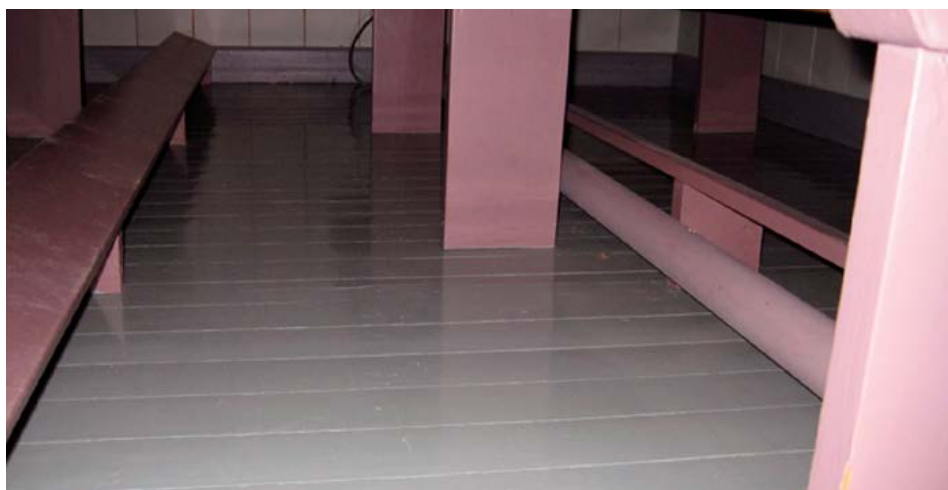
Bild kyrka 5.3: Radiatorer under bänkarna.
