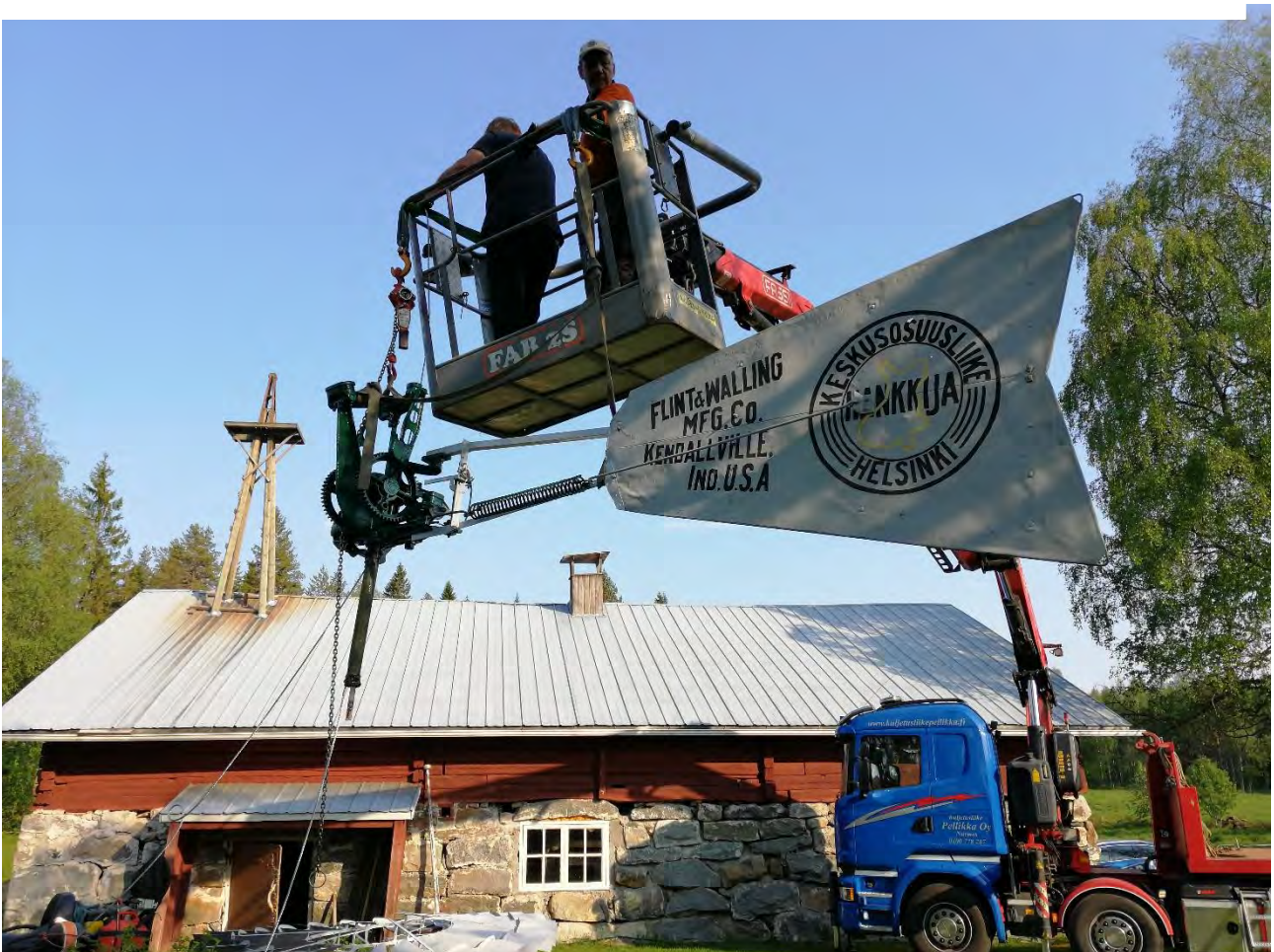
Martti Lohtander (vas) ja Martti Savolainen kiinnittivät pyrstön koneistoon ennen sen nostoa torniin. Edellistalvena murtunut lipputanko toimi asennustelineen. Alakuvassa koneiston nosto torniin.
