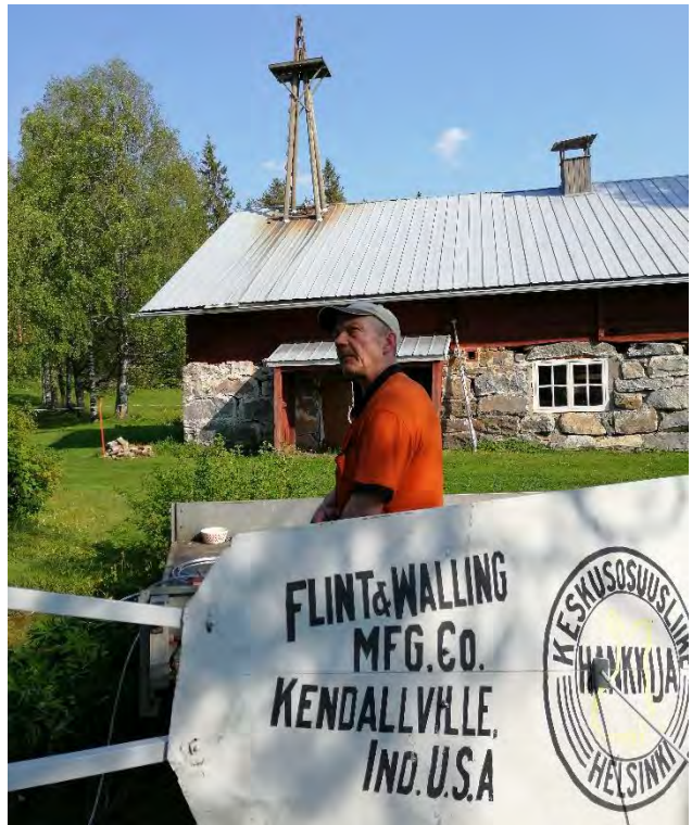
Martti Lohtander (vas) ja Martti Savolainen kiinnittivät pyrstön koneistoon ennen sen nostoa torniin. Edellistalvena murtunut lipputanko toimi asennustelineen. Alakuvassa koneiston nosto torniin.
