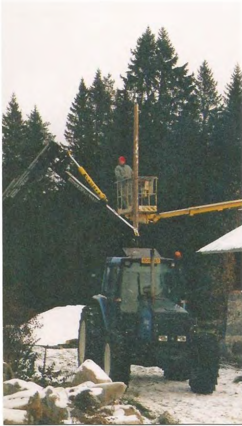
Tornin uusien jalkojen nosto.
