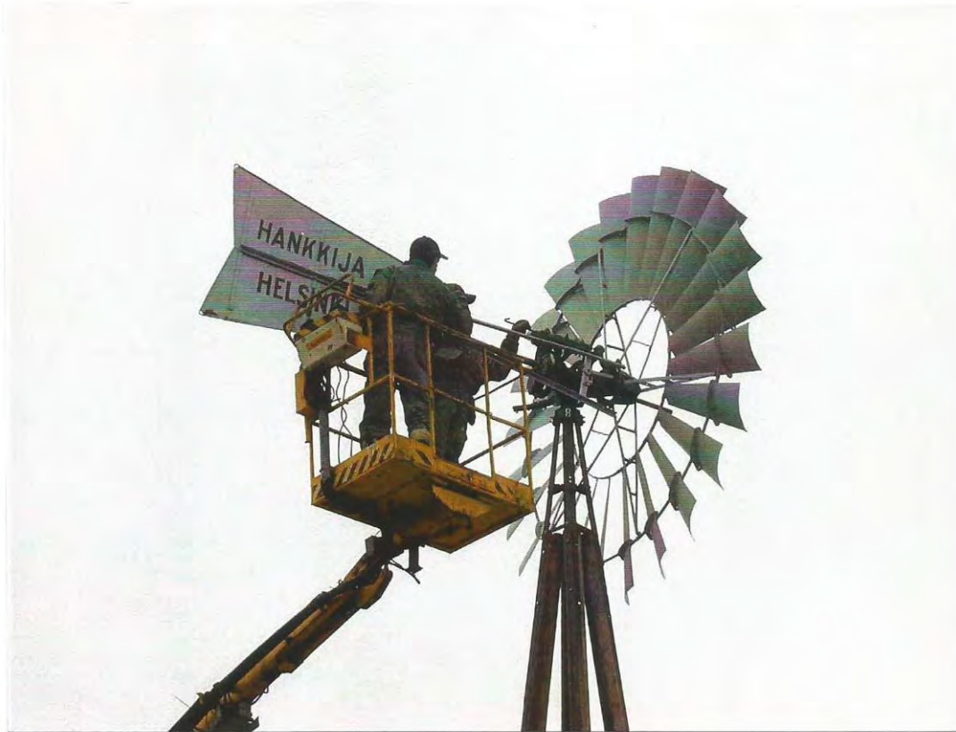
Pyrstön kiinnitys käynnissä.
