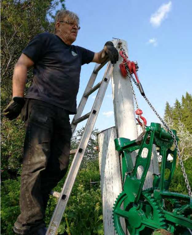
Martti Lohtander (vas) ja Martti Savolainen kiinnittivät pyrstön koneistoon ennen sen nostoa torniin. Edellistalvena murtunut lipputanko toimi asennustelineen. Alakuvassa koneiston nosto torniin.
