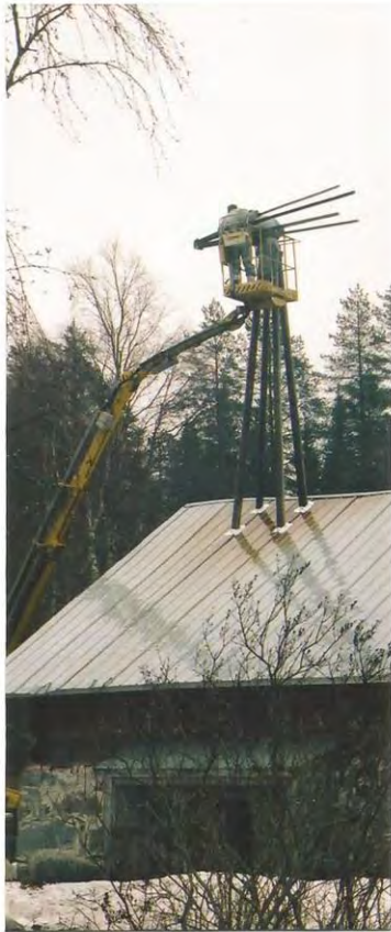
Tornin metallijatke paikoilleen.
