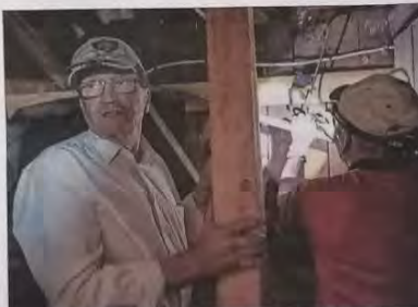
Tuulimoottorin jarruvaijeri pujotetaan katon läpi sisälle navettaan. Vaijeria asentamassa Martti Savolainen (oik.) ja Pekka Piironen.
